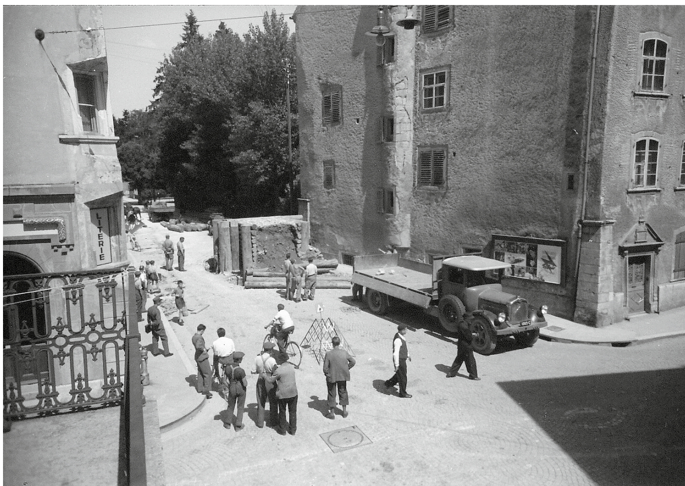
Un barrage antichar en construction au bas de la rue Pierre-Péquignat...
