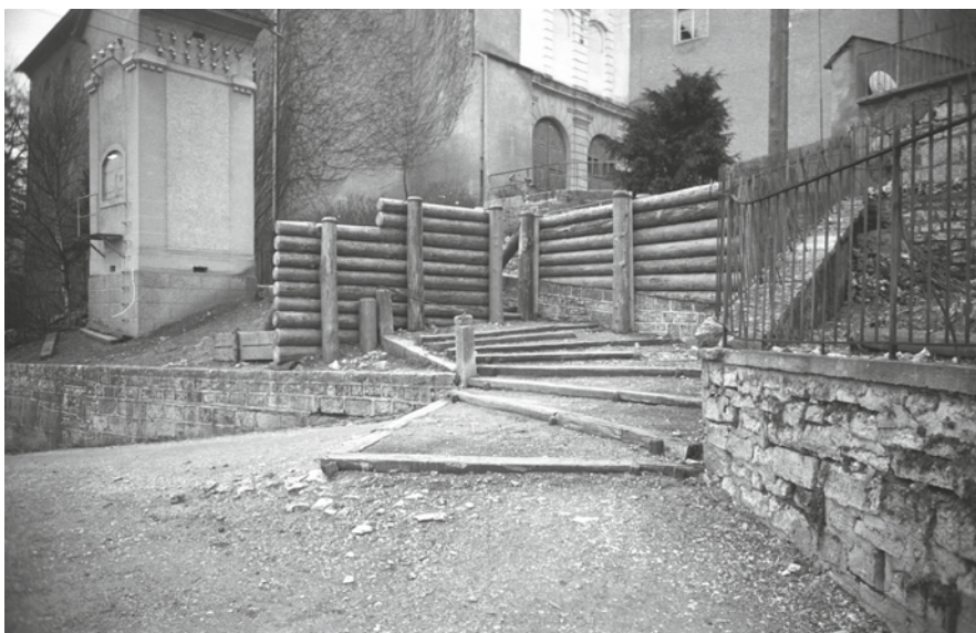
Un barrage en construction en dessous de l'église des Jésuites...
